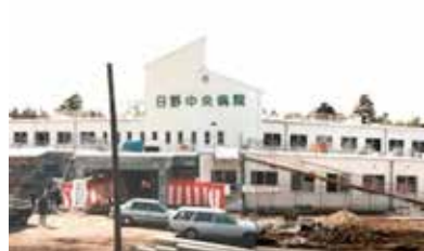
日野中央病院（現日野記念病院） 定礎式（昭和60年）
